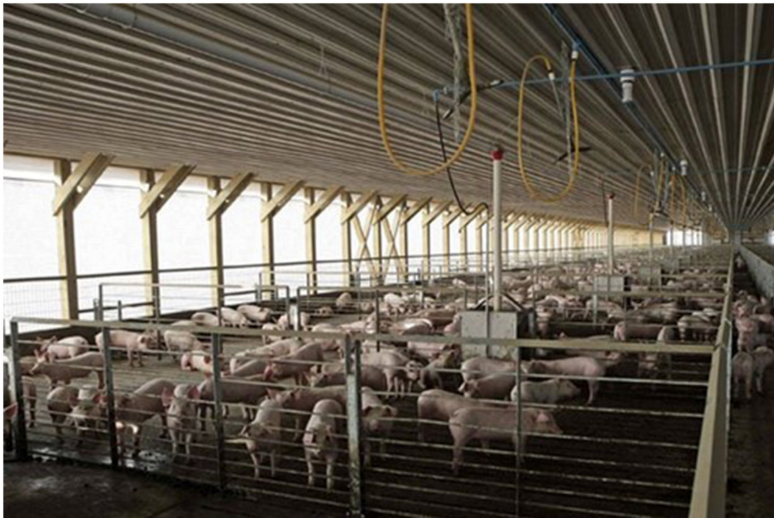
FIGURE 3 Interior of the Maxagro plant, Ñuble. Source: La Discusión (2021).
