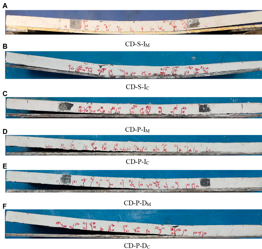
FIGURE 7 Failure of the steel-UHPC composite bridge deck. (A) Specimen CD-S-I M . (B) CD-S-I C . (C) CD-P-I M . (D) CD-P-I C . (E) CD-P-D M . (F) CD-P-D C .
